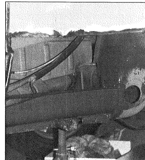
Hier een kijkje achter het plaatwerk boven de kriksteun. De kokerbalk is al vervangen.
